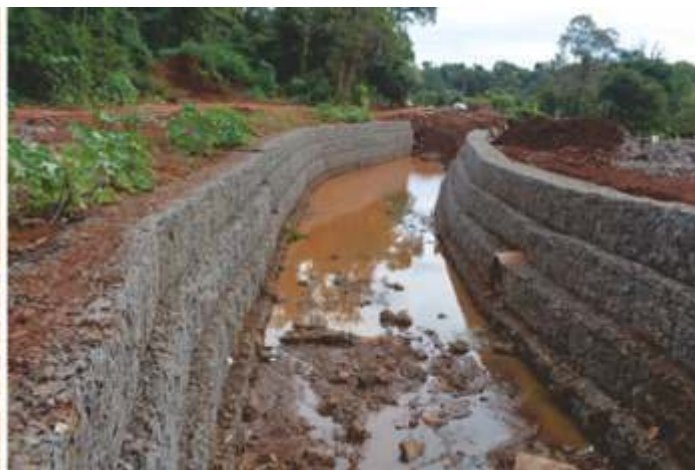
Gráfico 4: Canalización a cielo abierto, realizada
