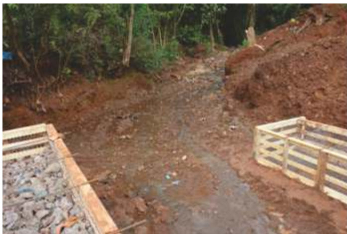
Gráfico 3: Armado de los gaviones de basalto.
