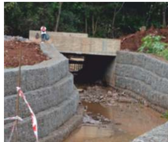
Gráfico 5: Canalización cerrada, realizada.
