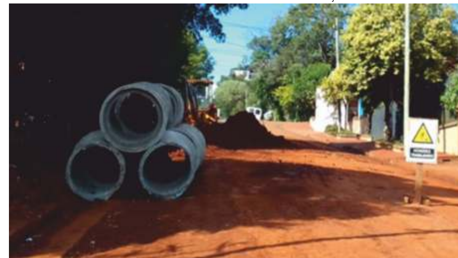
Gráfico 6: Ejecución de colectora cloacal
