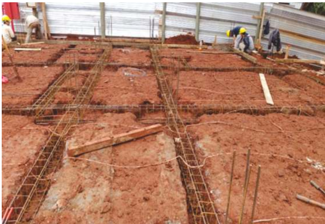
Armado de la malla de Puesta a Tierra con conectores "C"
