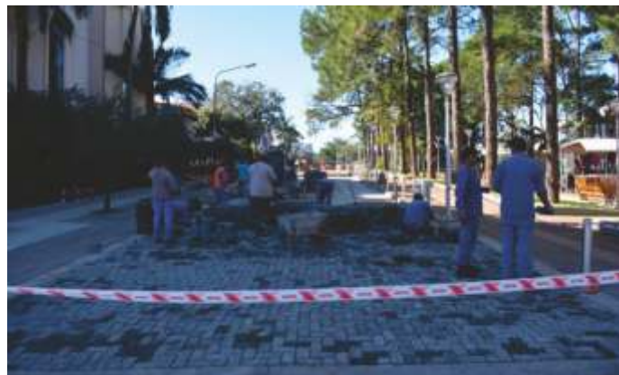
Gráfico 2 y 3: Ejecución de la calzada, con pavimento articulado y de la vereda. Fuente: elaboración propia.
