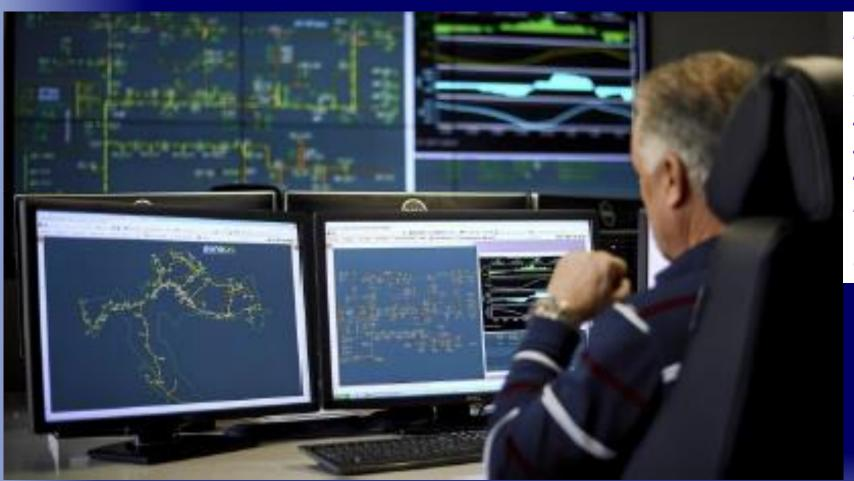
FUNCIONES BASICAS DE **UN SISTEMA SCADA** 1 AUTOMATIZACION **2 SUPERVISION 3 MANEJO DE ALARMAS** 4.GENERACION.DE **REPORTES** 5.INTERCONEXION CON **OTROS SISTEMAS**
