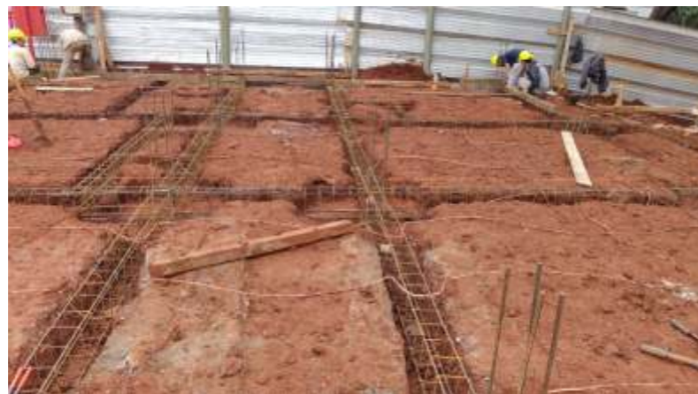
Armado de la malla de Puesta a Tierra
